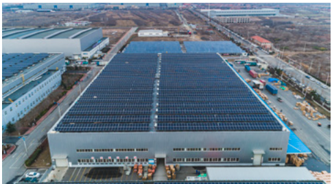
▲ 一汽解放青岛厂停车场等闲置屋顶安装的光伏板
